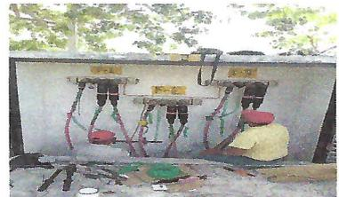
Reparación de murete derivador y Transformadores de 75 y 100 KVA y reconexión del servicio de alumbrado público en Parque Campeche el 31 marzo 2022.
